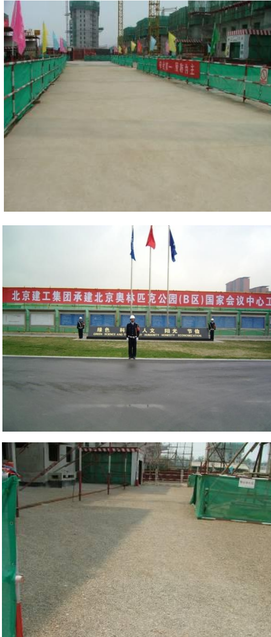
图 2-14 道路硬化情况
