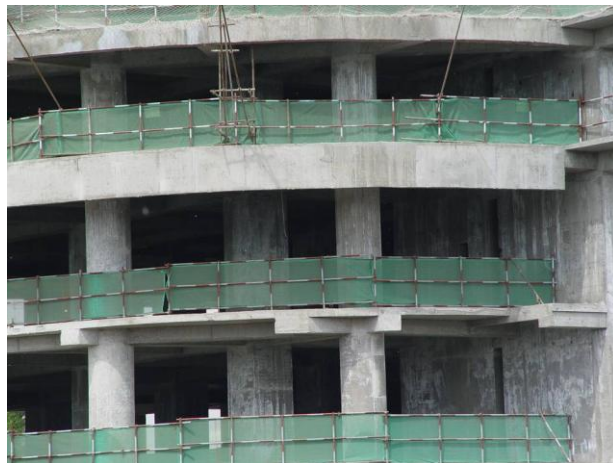
图 3-20 楼层临边防护
