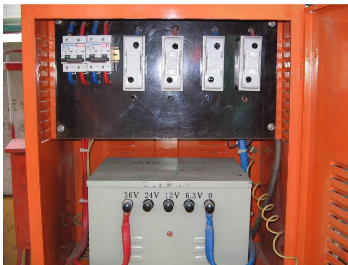
图 7-18 低压变压器
