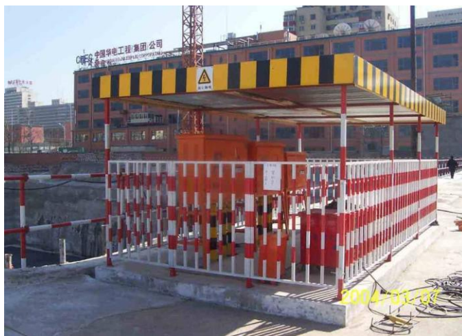
图 7-15 配电箱安装示意图
