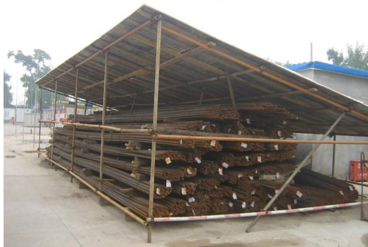
图 2-6 材料保护措施示意图
