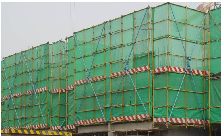
图 3-16 外脚手架防护
