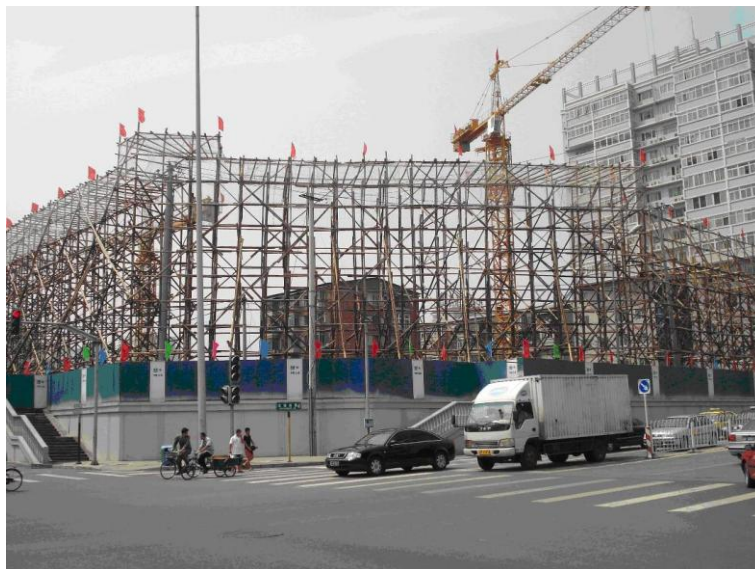
图 7-7 外电线路防护
