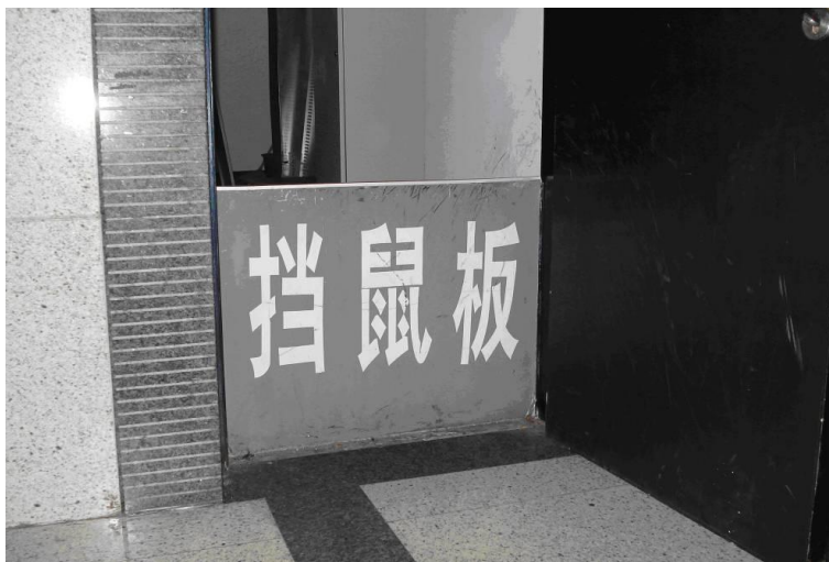
图 7-8 挡鼠板示意图
