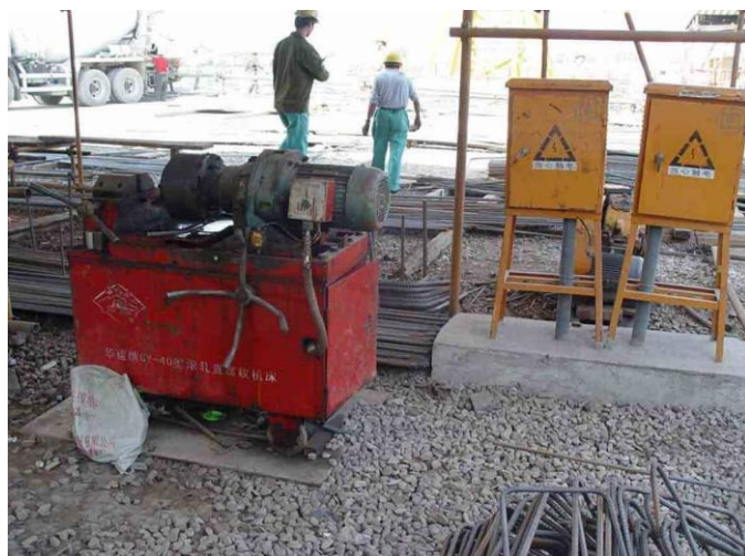
图 7-14 开关箱与设备之间的距离应在 3 米之内
