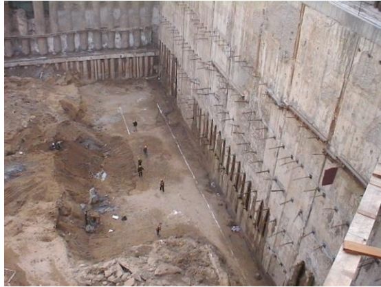
图 2-26 基坑支护
