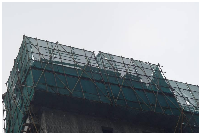
图 3-12 外挂脚手架示意图
