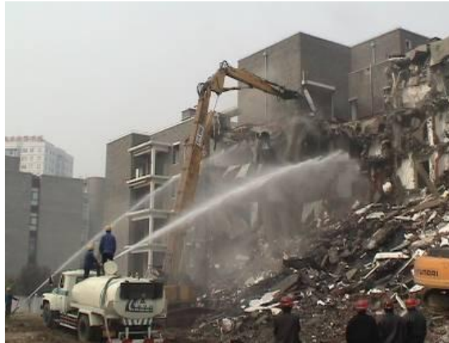
图 2-20 拆除现场降尘措施
