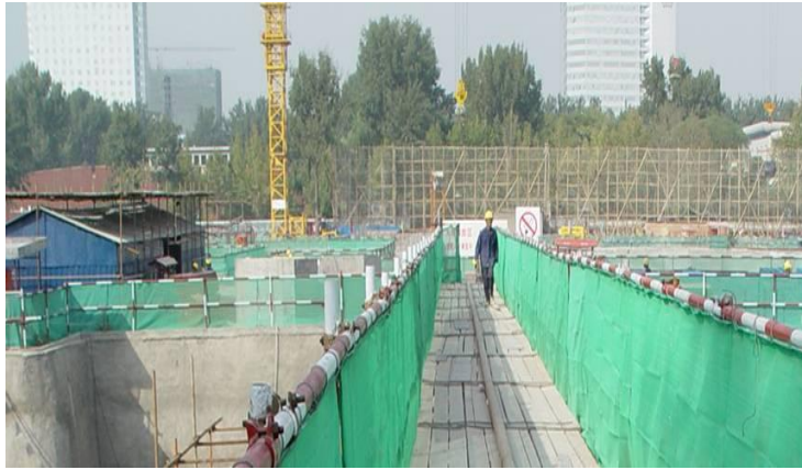
图 3-1 爬梯、马道示意图及照片
