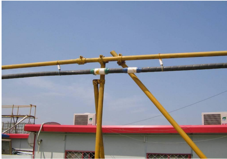
图 7-12 电缆架空示意图
